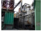
紙くず、木くず、繊維くず、動植物性残さ(生ごみ)のうち、リサイクル不可能なものを焼却処理する施設。平成14年12月からのダイオキシン類対策に適合。二次燃焼室で不完全燃焼を防止しダイオキシン類を分解、排ガス冷却設備でダイオキシン類の発生(再合成)を防止、消石灰を噴霧し酸性よりの排ガスを中和、活性炭を噴霧しダイオキシン類等の有害ガスを吸着、サイクロンとバグフィルタの高度な集じん器でばいじんを除去。環境汚染を可能な限り最小限に抑える。
